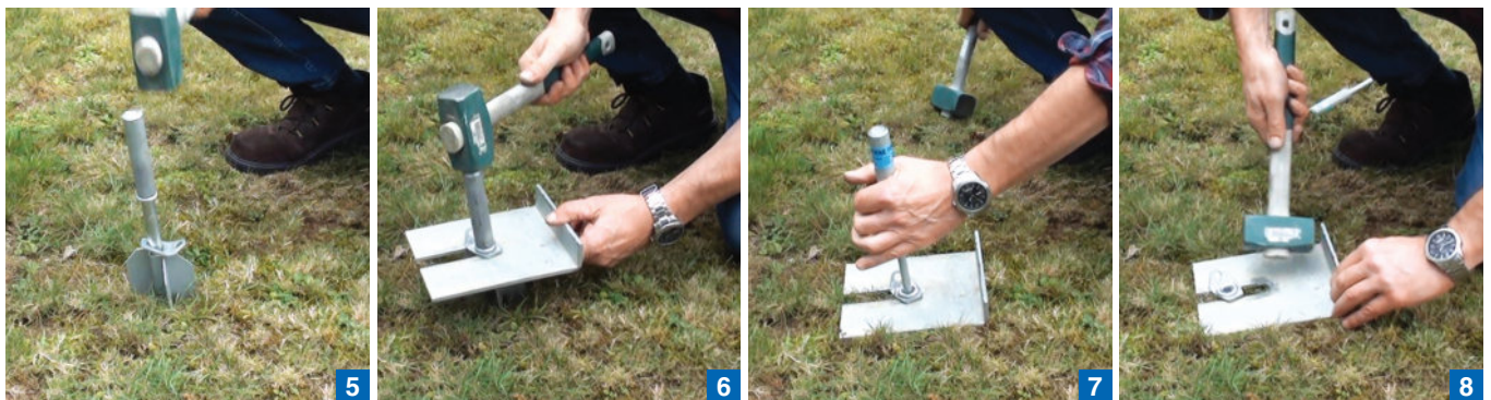
5 Commencer à enfoncer l'amarre dans le sol à l'aide de l'outil d'enfoncement.
