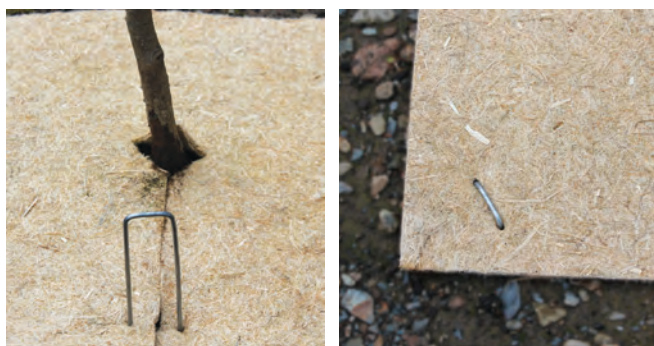
Fissaggio di una piastra di protezione intorno al piede dell'albero con le graffette.
