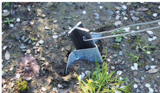
Ancoraggio rinforzato con l'aiuto della croce.
