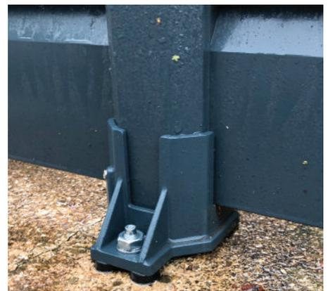
Fixation d'une platine de palissade sur béton.
