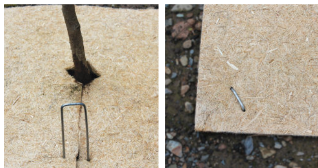
Fixation d'un feutre de protection autour d'un pied d'arbre par agrafes.
