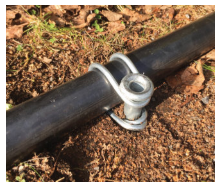
Tube fixé à l'aide de l'attache en fil et de l'amarre.
